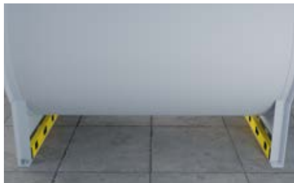
Nivelez soigneusement le ventilateur sur les fondations
